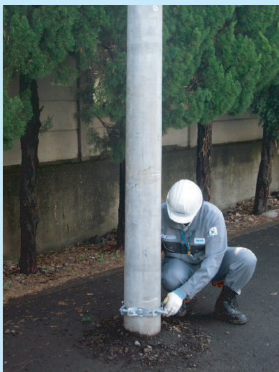
①補強板取付位置に合わせて補助バンドを取付け
