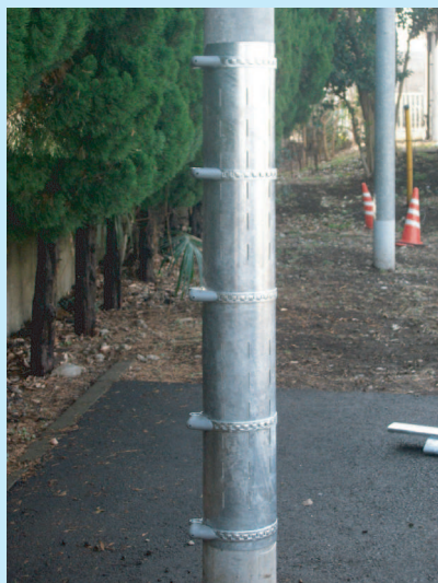
⑥IBT保護カバーを取付けて 完成
