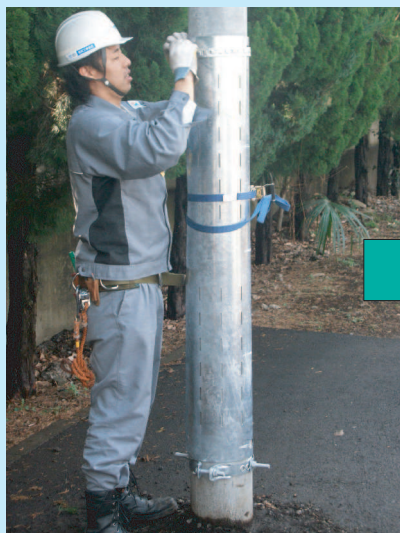
④Bバンドを補強板に均等 間隔で5本取付け
