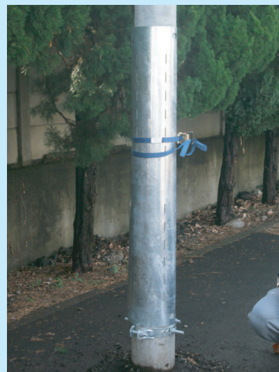
③荷締機で補強板を仮固定
